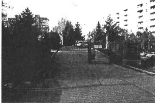
▼ Pohľad na vstup do areálu školy.
